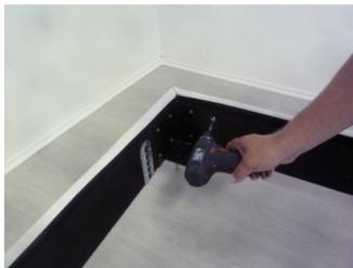
Bett auf die FüÙe stellen und Fußteil montieren. Schrauben (M6x20) immer leicht anziehen, dann festziehen.
